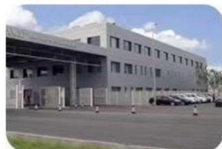
工場・物流倉庫
