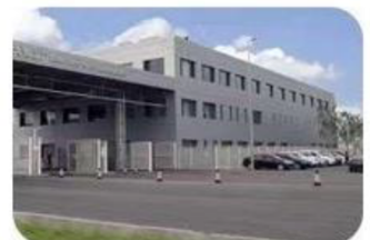
工場・物流倉庫
